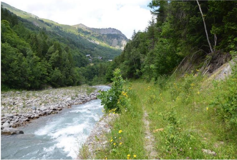
Piste sous laquelle sera enterrée la conduite
