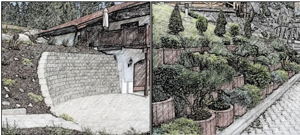
Exemples de soutènements maçonnés
