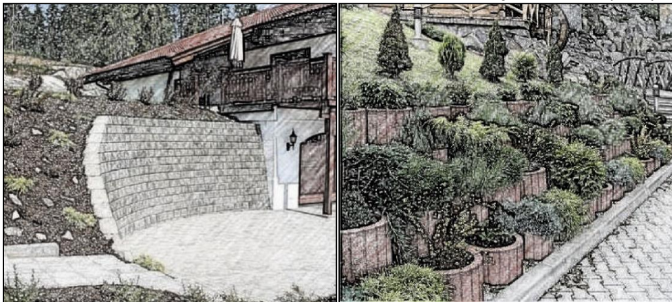
Exemples de soutènements maçonnés
