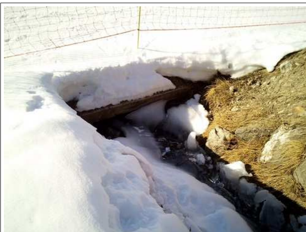
▲ L'entrée de l'ouvrage de franchissement de la piste de ski par le ruisseau des Choseaux (cote 1540)
