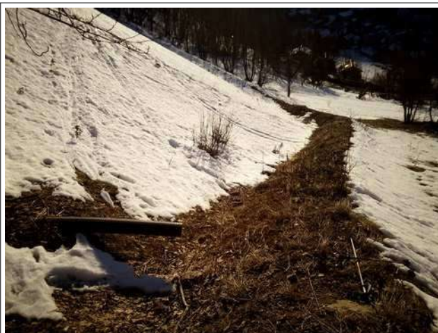
▲ Buse d'évacuation d'eaux de drainage et cavalier en pied de bourrelet
