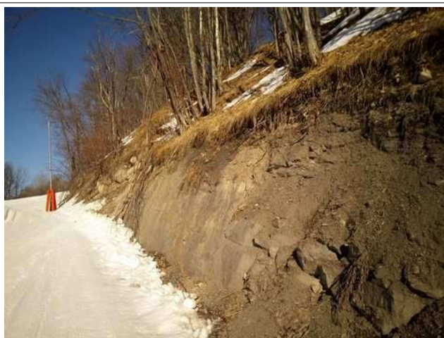
▲ Affleurement de houiller dans le talus de la piste à l'extrémité Nord de la zone très instable
