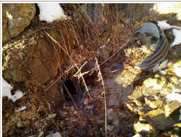
▲ L'entrée de l'ouvrage de franchissement de la piste de ski par le ruisseau de la Combe de Point Rogereuil (cote 1505)
