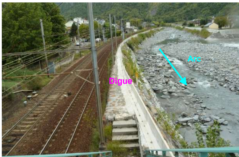
Figure 14 : Brèche 4 : Merlon Saint Michel Rive Droite
