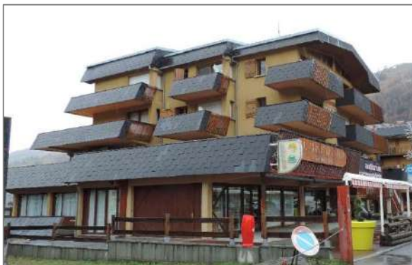
Construction récente présentant des façades mixtes : enduit, bois foncé sur la partie haute de la façade et pierres apparentes par touches. Les gardes corps sont en bois à barreaudages verticaux.
