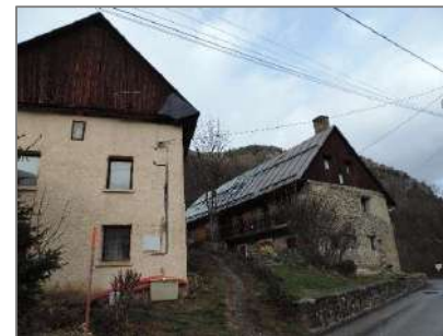
Façade en pierres, combles en bois, toitures à 2 pans en tôle.
