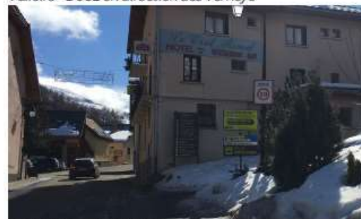
Les Verneys - Entrée Nord
