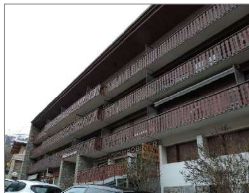
Constructions présentant des façades sombres aux matériaux de types ardoises, bois sombres, volets roulants, toitures à pentes faibles ou 1 pans, gardes corps variés (barreaudages verticaux en bois ou pleins en matériaux identiques à la façade) :
