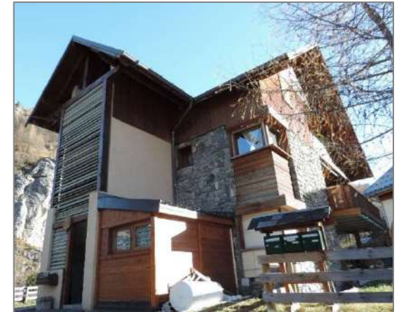
Éléments architecturaux nouveaux : façade arrondie, couleur sombre, brises soleil en bois, pierres apparentes en parements.
