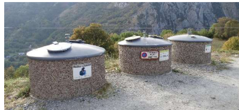
Exemple de conteneurs semi-enterrés sur Valloire
