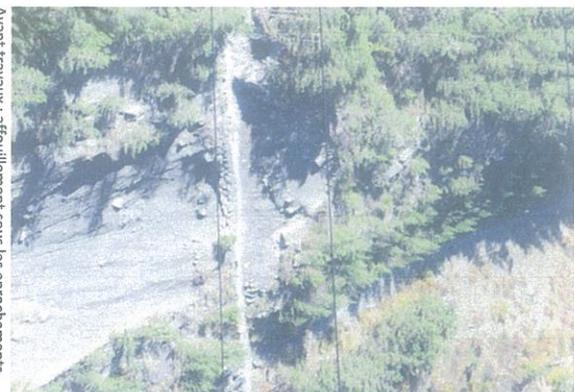
Avant travaux : affouillement sous les enrochements
