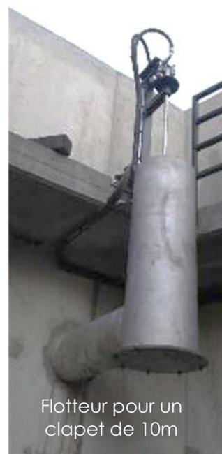
Flotteur pour un clapet de 10m
