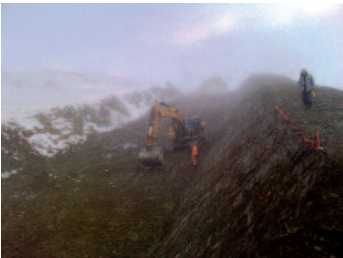
Le Half-Pipe (reconstruction de la pré-forme en terre aux normes FIS)
