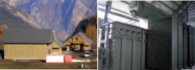
Vue d'ensemble du chantier Le transformateur
