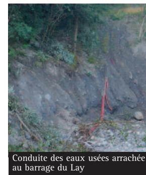
Conduite des eaux usées arrachée au barrage du Lay
