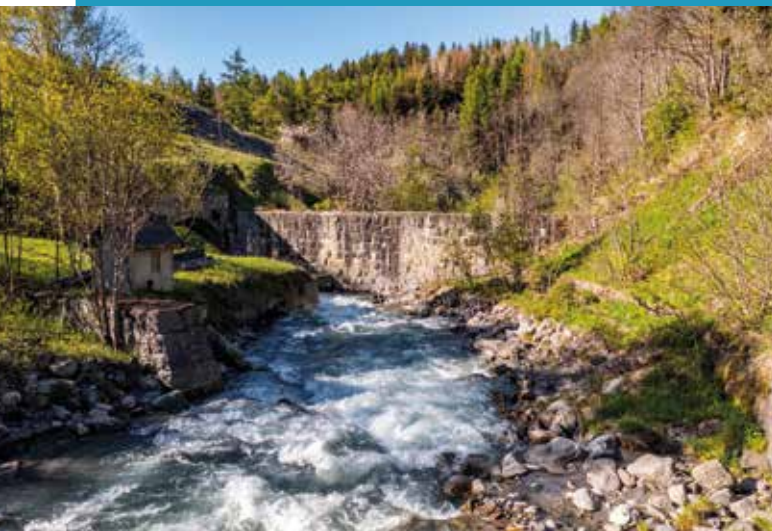
Figure 2 : Vue du site de la future prise d'eau
