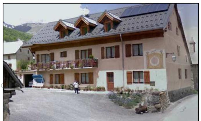
La toiture est en tôles de couleur grise. La pente de toit Sud présente 3 jacobines. des panneaux solaires se trouvent sur la pente de toit Sud.
