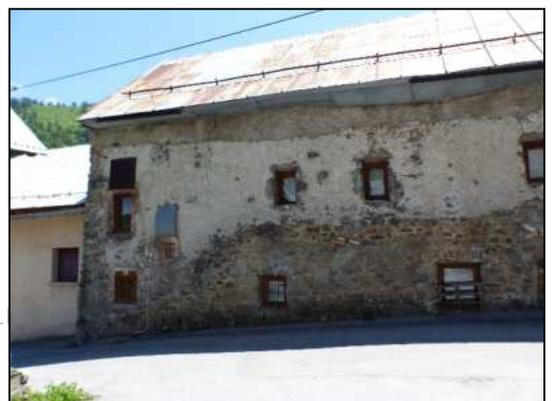
La toiture est en tôles de couleur grise. Aucune ouverture en toiture.
