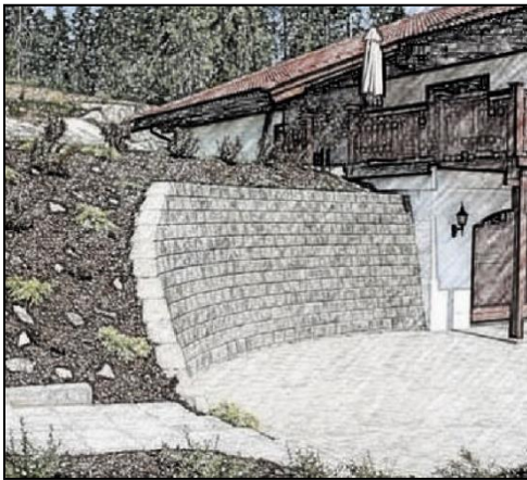
Exemples de soutènements maçonnés
