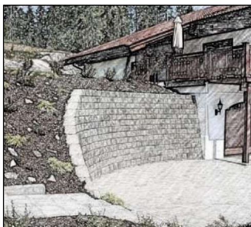
Exemples de soutènements maçonnés
