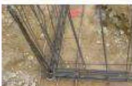
Nœud de chaînage - Continuité mécanique
