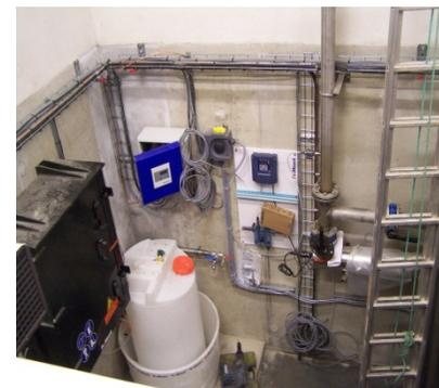
*Electro-chloration : solution recommandée compte tenu des conditions d'exploitation hivernale*
